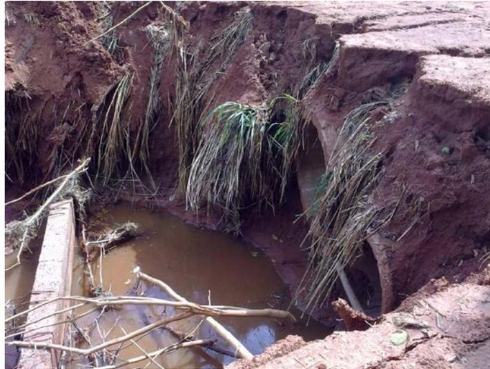
O grande fluxo d'água derrubou o dissipador e o final dos tubos da galeria
